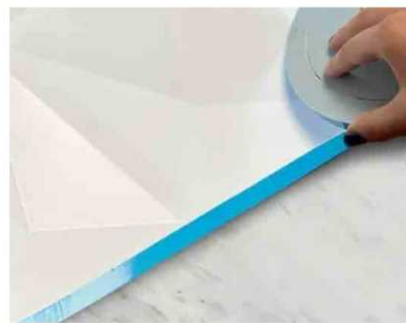
3. Pega cinta doble contacto en la parte posterior del panel (bordes y centro)
