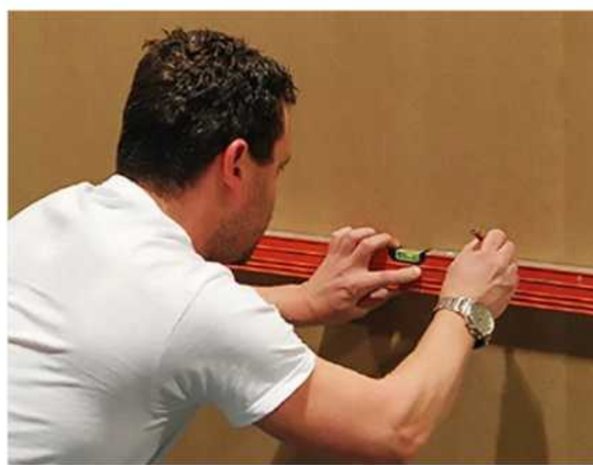
2. Marca la pared con las dimensiones del panel para garantizar una instalación recta
