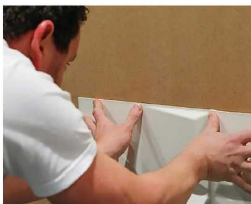
4. Pegue y presione las piezas sobre las líneas marcadas en la pared
